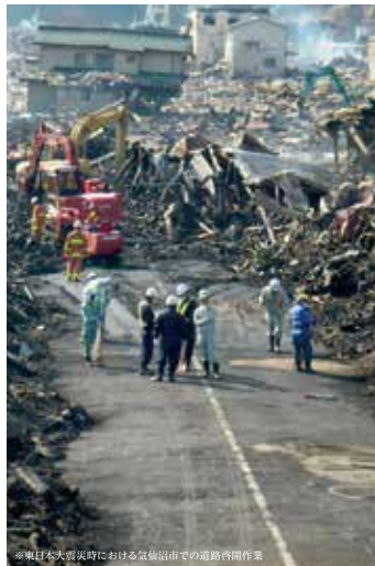
※東日本大震災時における気仙沼市での道路啓開作業
